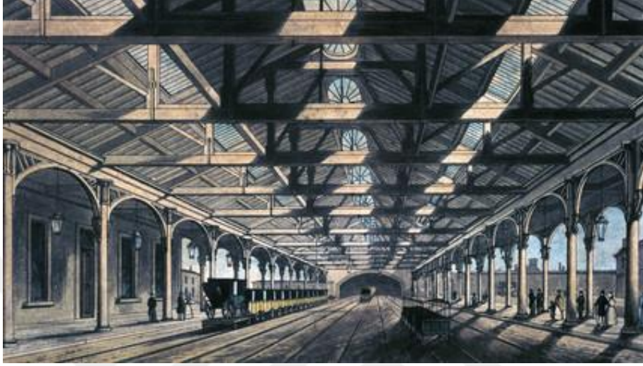
Şekil 3.18 Lime Street İstasyonu raylar ve sol tarafta hizmet birimleri – 1839 (NRM, b.t.)
