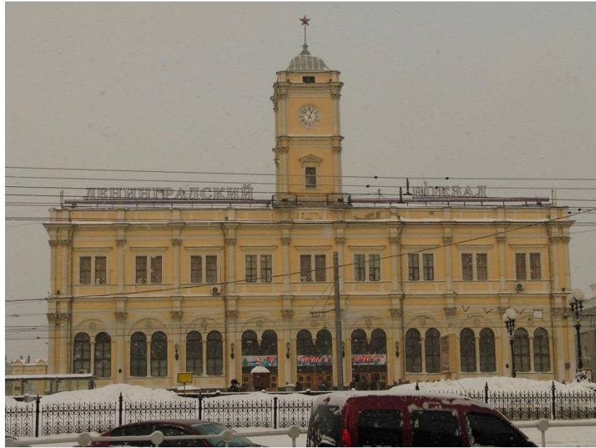
Şekil 3.75 1849 Leningrad İstasyonu cephesi (Wikimedia, 2010)
