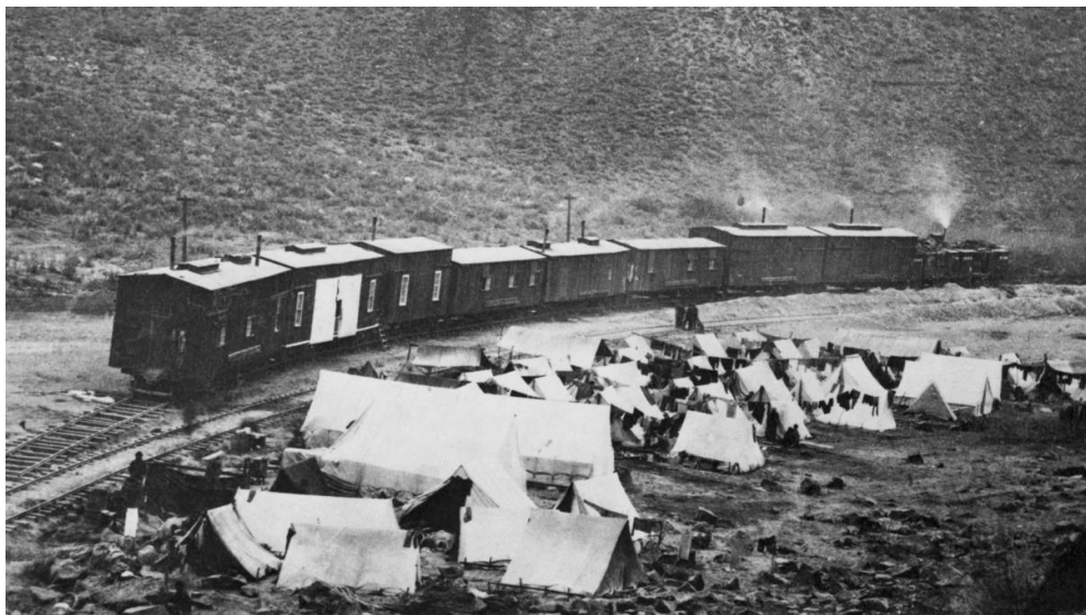
Şekil 3.53 Demiryolu inşası çadır alanı (Independentturkish, 2019)
